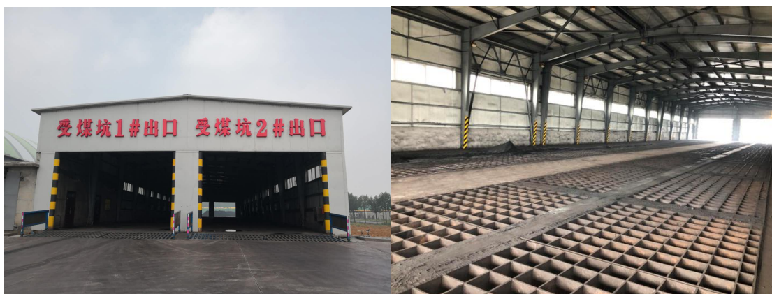
图 6.2.1-1 现有受煤坑及卸煤坑
